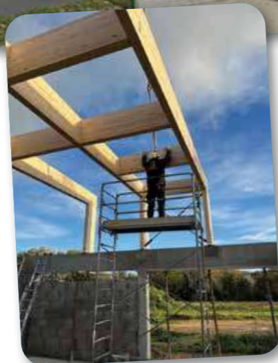
Pose charpente sur le bâtiment des kinés
