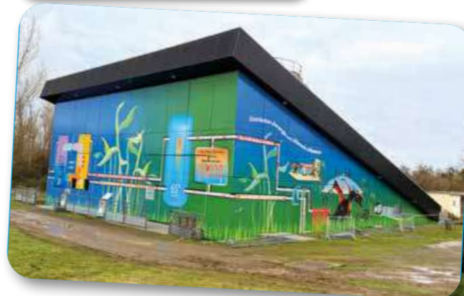
Nouveaux adhésifs extérieurs pour la centrale thermique qui permet de chauffer le centre aquatique et Terre de dragons
