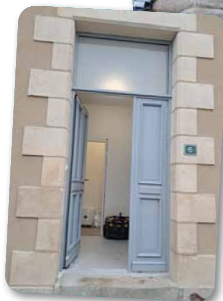
Réhabilitation de la maison de l'école
